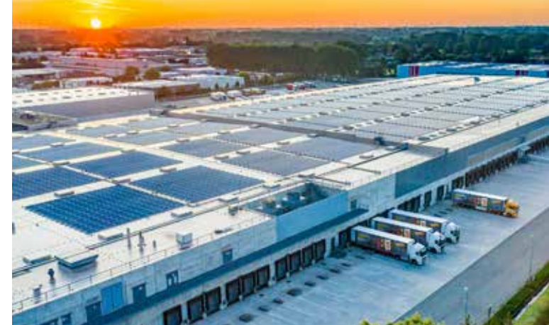
Centre de distribution de Saint-Nicolas avec 7 200 panneaux solaires sur le toit.
